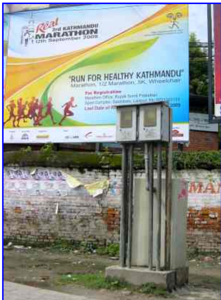
信号コントロール機。この付近に日本援助の恒久的看板が設置されていた。
