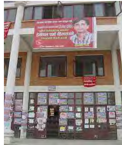
右ビル正面（巨大写真はM系）
