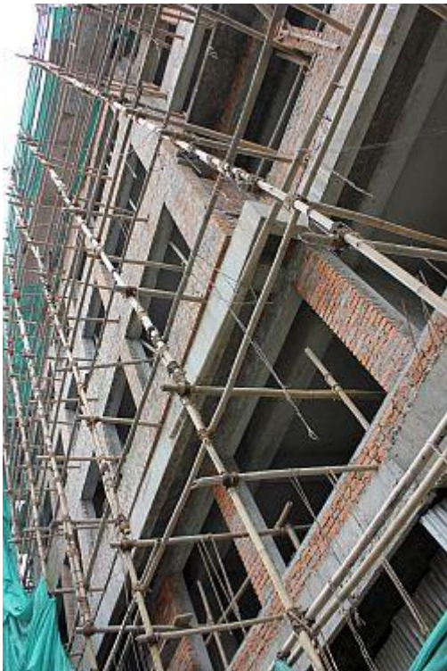
建設中7階建てビル。足場は竹。
