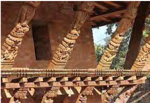
■レンガ粉つくり(?)／新しい屋根支柱(道路側)
