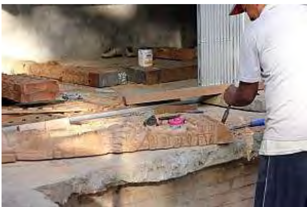
■ 寄進者表とその横の作業部屋／屋根支柱制作
