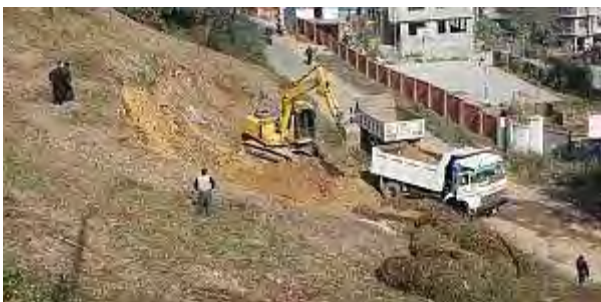
■建設現場を見る関係者
