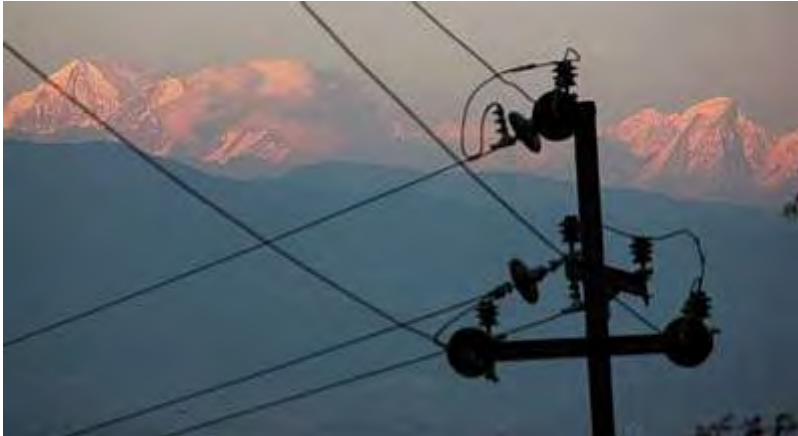
■ 電柱と送電線
