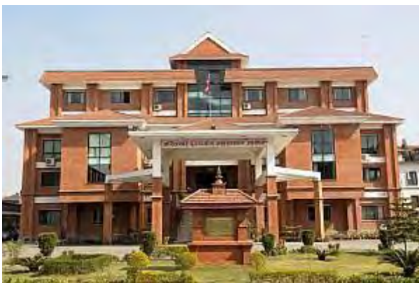
■権力乱用調査委員会ビル(タンガール)
