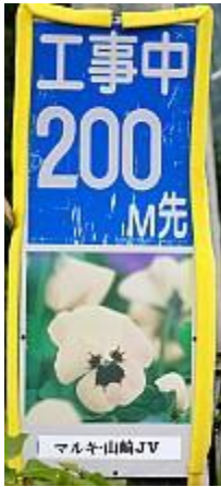
■森本インター工事（2014-6-17）
