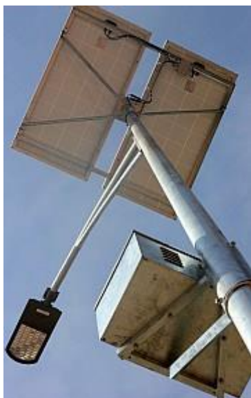
■上から太陽光発電板，照明板，蓄電池箱／LED 電球照明板
