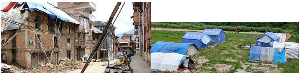
■ 震災被害建物、橙色標識は OXFAM / 中国提供テント
