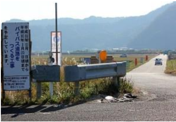
■間人付近のバイパス工事
