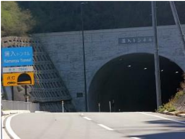
■蒲入トンネル
