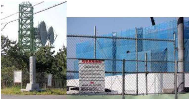
■穴文殊参道入口左側の空自レーダー／同右側の建設中米軍ビル
