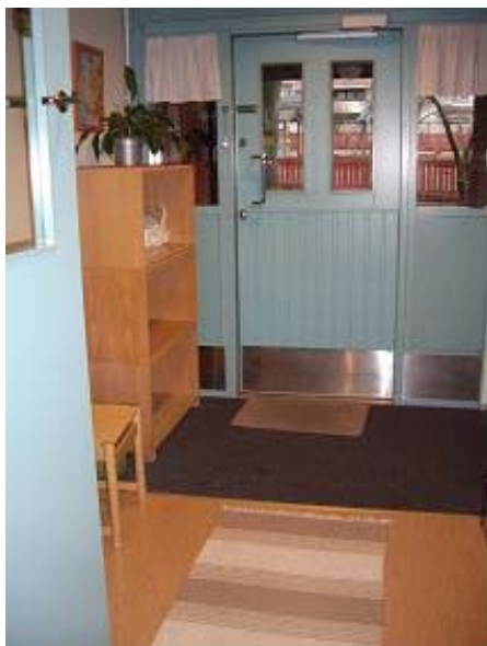
施設内の扉。子どもの手が届かないよう、ノブが高い位置に設置してある。 (2007・11・21 衣川)
